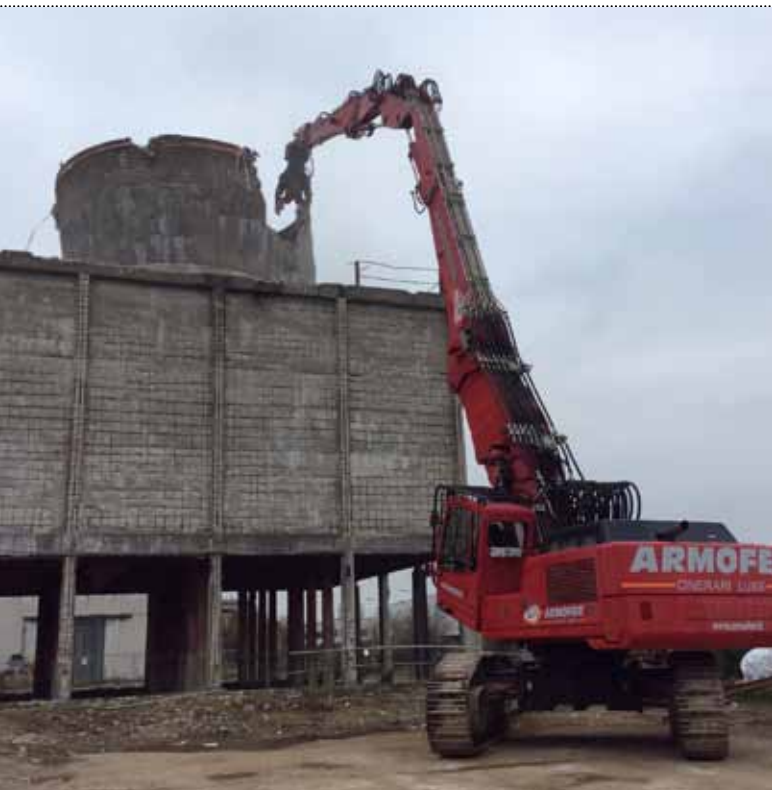
Demolizione meccanica della torre evaporativa, con Liebherr 954
