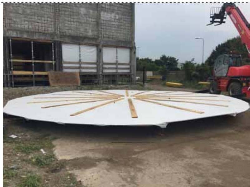
Realizzazione a piè d'opera del "tappo" per la bocca sommitale della torre con struttura in ferro e legno.
