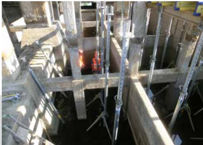
Realizzazione del plancito in tavole da ponte, piano di lavoro per la bonifica
