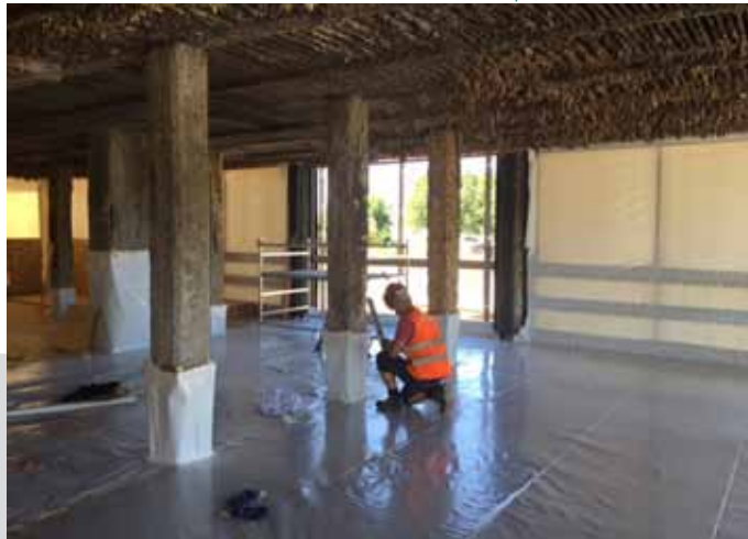
Realizzazione dell'area confinata: stesura del triplo telo di PVC
