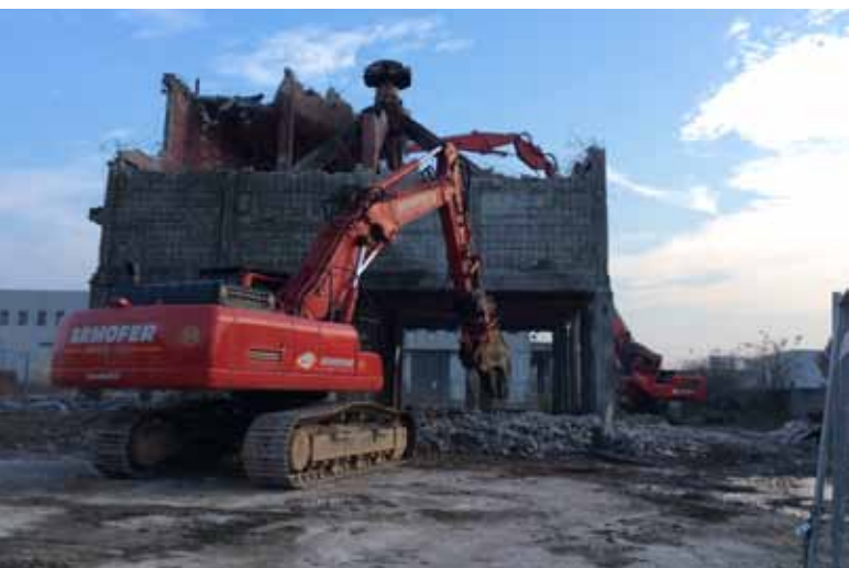
Demolizione meccanica della torre evaporativa, con Liebherr 954
