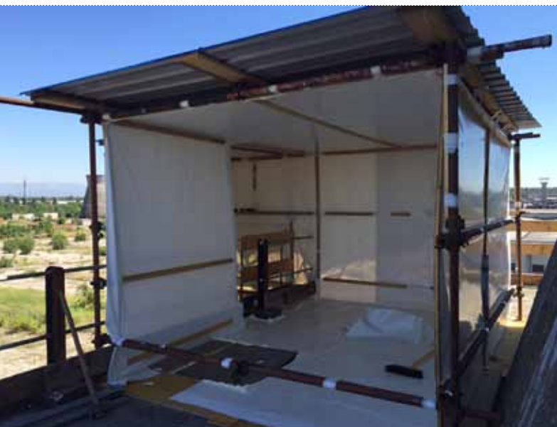
Realizzazione delle strutture in tubo e giunto e PVC per UDM e UDP
