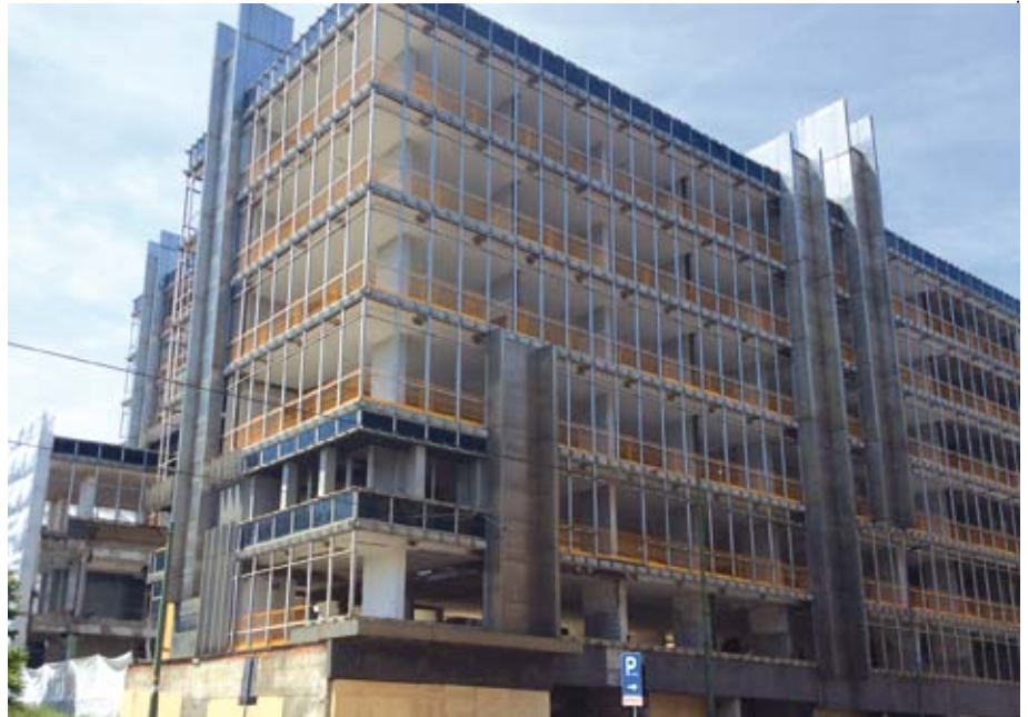
Vista generale del cantiere dall'esterno
