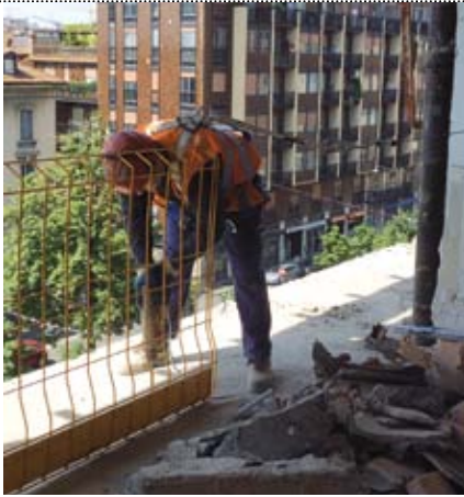
Montaggio del parapetto di protezione in sicurezza
